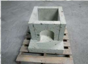
③樋口板を組む
