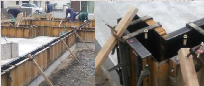
①ワンタッチドライバーとレベルポインターを使用して高さを調整する。
