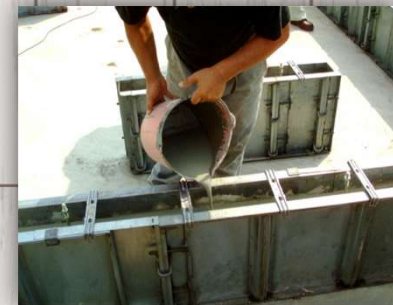
④レベルポインターの先端までレベリング剤を流し込む。
