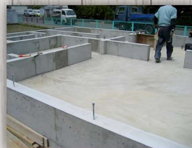
基礎工事完了
