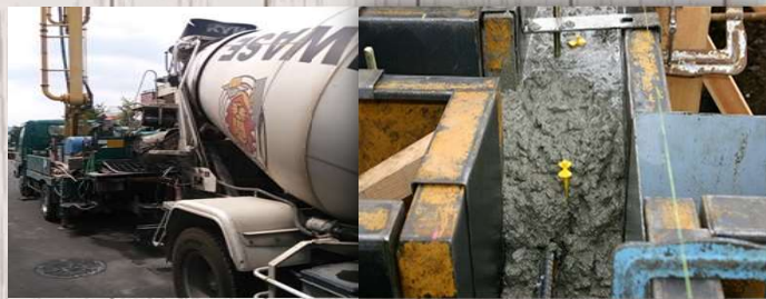
②生コンを微調整ハンドルまで打設する。
