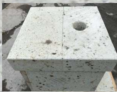
11 屋根板煙突穴を載せる
