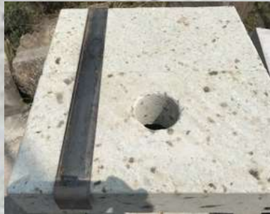
12 落下防止金具を取り付ける
